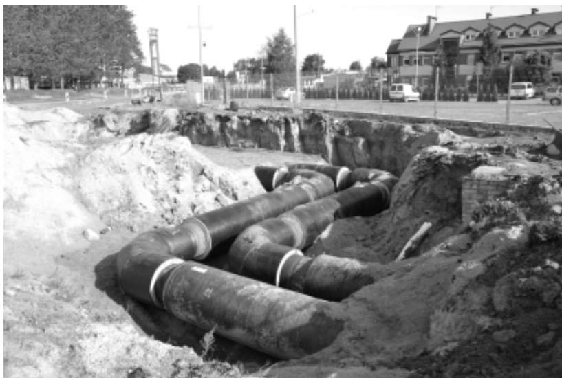
Budowa sieci ciepłowniczej. Fot. archiwum MEC
