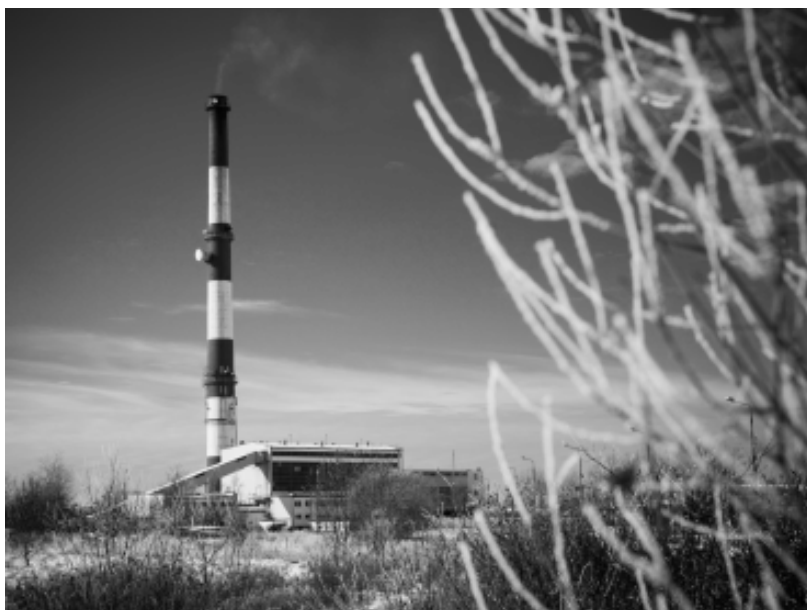
Kotłownia FUB zimą. Fot. Dawid Perz
